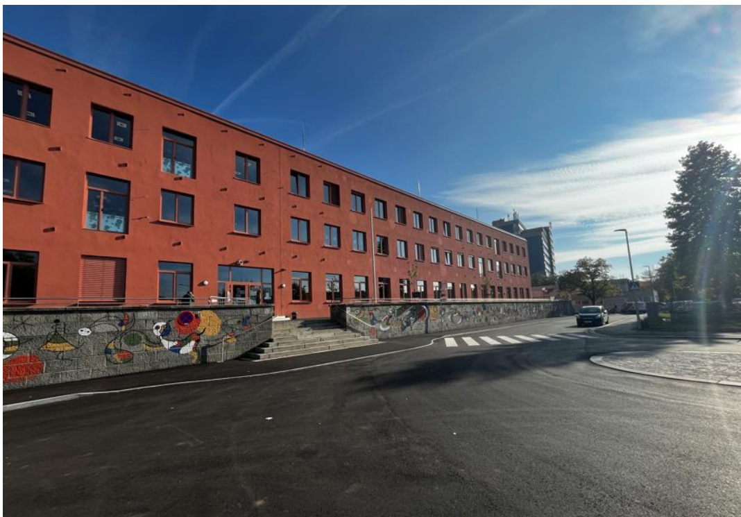
Westfassade (fehlende Balkone) (Bildquelle: ILG)
