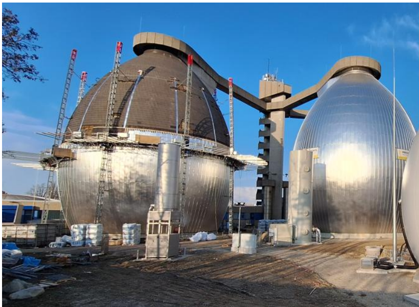
Abb. 2: Aktuell: Ummantelung Faultürme (Foto LINZ AG)
