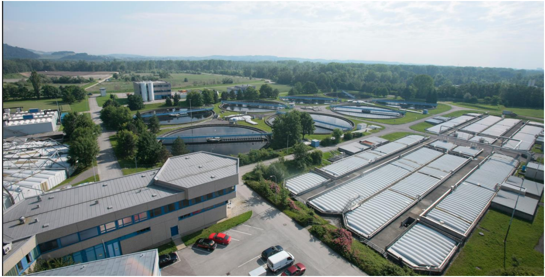
Abb. 1: Regionalkläranlage Linz-Asten (Foto LINZ AG)
