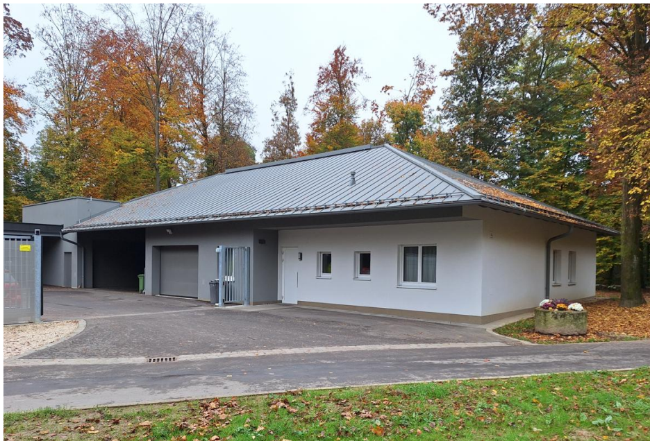
Neuzustand Gartendepot - Oktober 2024
